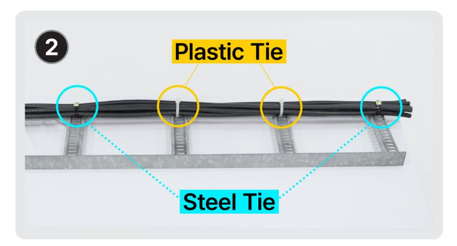
③ 플라스틱 타이는 몸쪽으로 당겨 조일 수 있도록 아래 그림 Φ와 같이 몸에서 먼 곳에서부터 먼저 넣습니다. 그리고 바인딩 후 케이블 고정과 관련 없는 끝부분은 아래 그림 ⑤와 같이 가위로 제거합니다.
